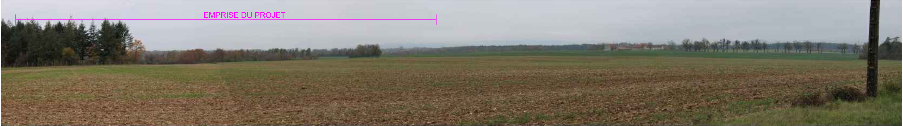
VUE 2 : Depuis la route D980 au niveau du lieu-dit "Ferme St-Georges"
