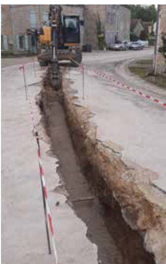
Réfection du réseau d'eau potable.
