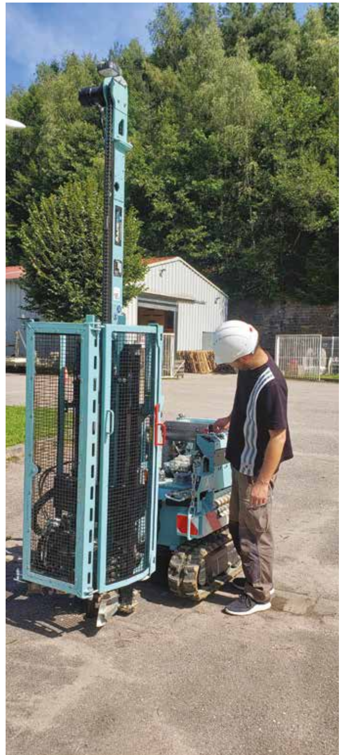
Réalisation d'un carottage
